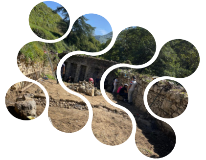
Chantier éducatif Lescun
